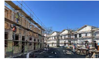
住宅建設作業の様子
